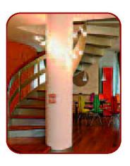
Per la casa di un single su due livelli è stata realizzata una scala con struttura in acciaio a vista, pedate in legno e pilastro portante utilizzato come fulcro dello sviluppo della scala e come elemento illuminante.
