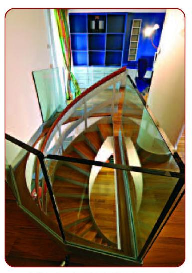
Nell'appartamento su due piani di un giovane committente è stata realizzata una scala con parapetti in cristallo, la struttura è interamente in acciaio con i gradini rivestiti in teak.
