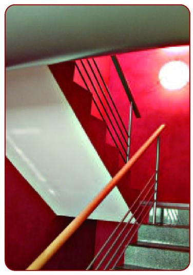
In una palazzina di uffici è stata realizzata una scala in muratura con rivestimento delle alzate e delle pedate in granito lucido e fresate antiscivolo sulle pedate. Barriera essenziale in acciaio e legno, l'atmosfera particolare è data dalle pareti trattate con vernice colorata morbida e dalla illuminazione a parete.
